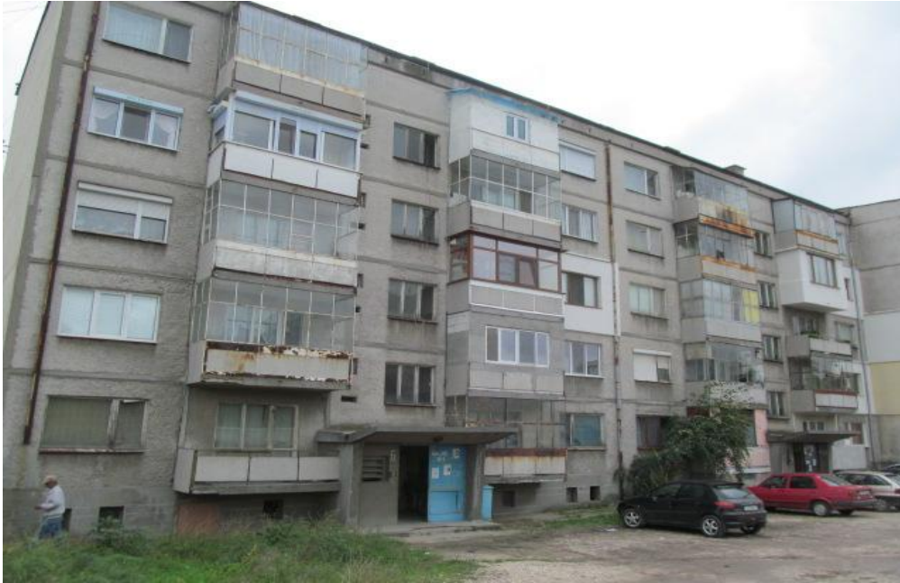
Бл. 6 , вх. „ А” , вх. „ Б”- фасада север
