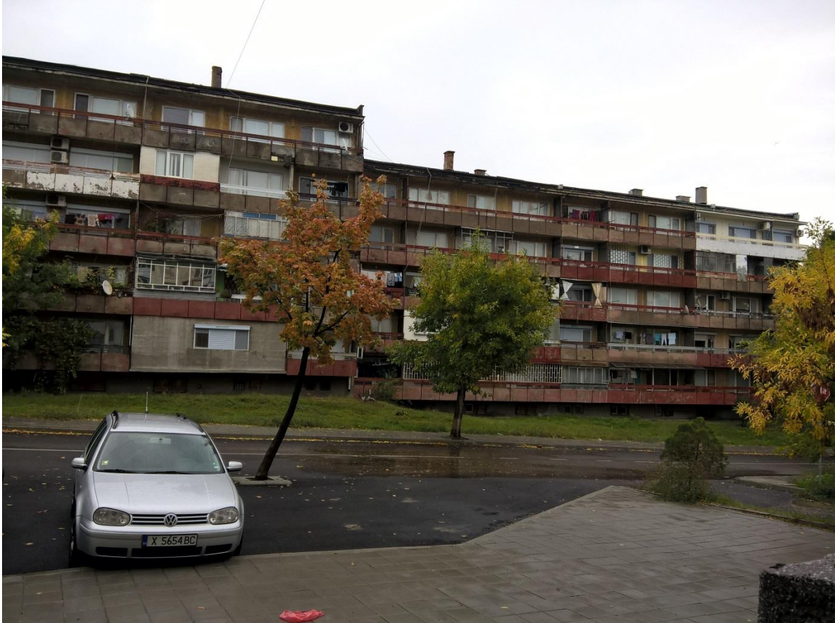
Бл. 14 - южна фасада
