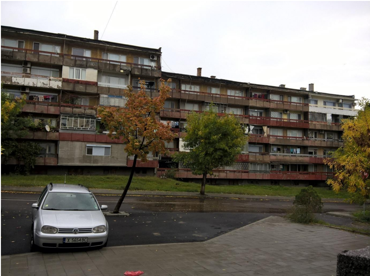
Бл. 16 - южна фасада
